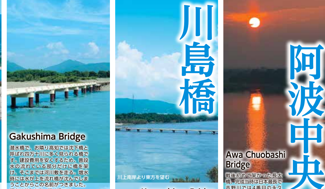
川上南岸より東方を望む
