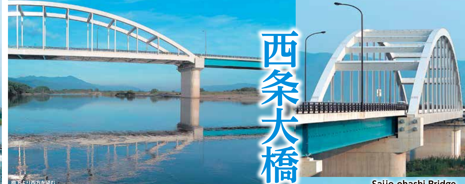
橋下より西方を望む
