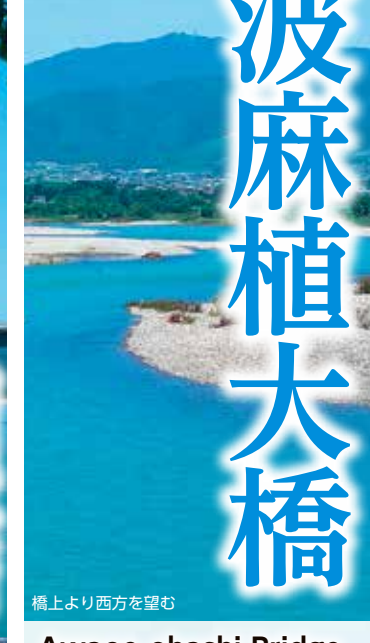
橋上より西方を望む
