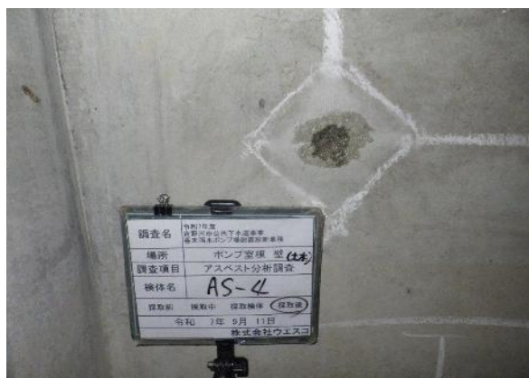
採取後 (補修後)
