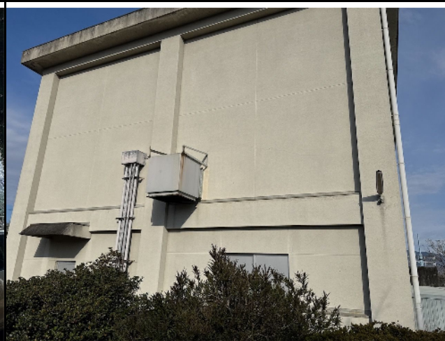
外壁 変質・損傷無し
