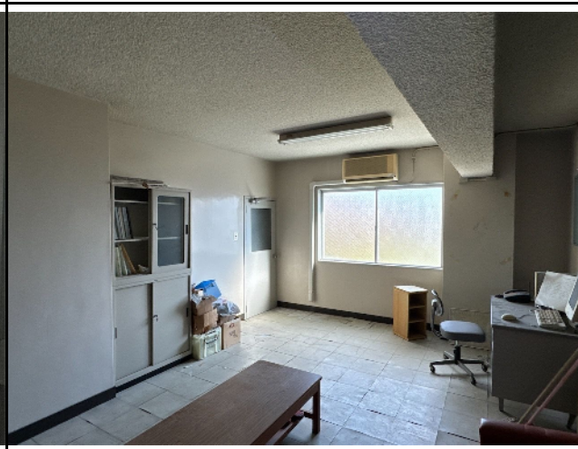
管理室 変質・損傷無し
