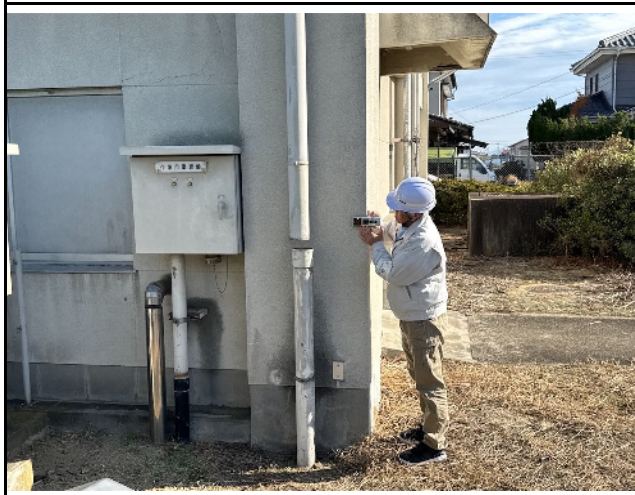
躯体 傾斜無し
