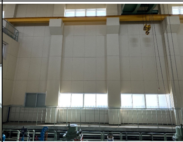
内壁 変質・損傷無し
