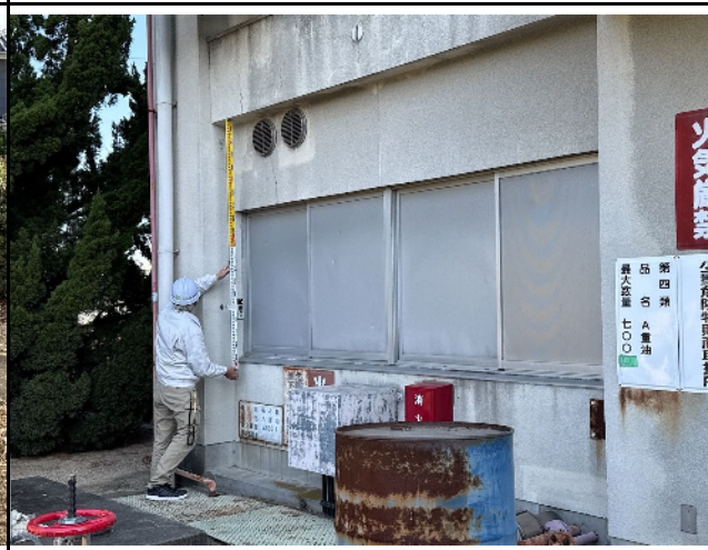
躯体 不動沈下無し
