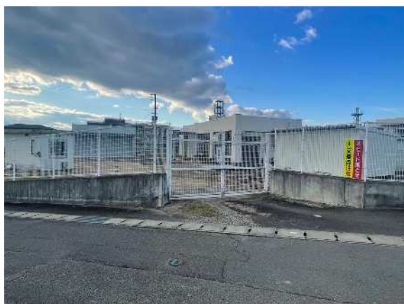
図 2-3 鴨島町浄水場
