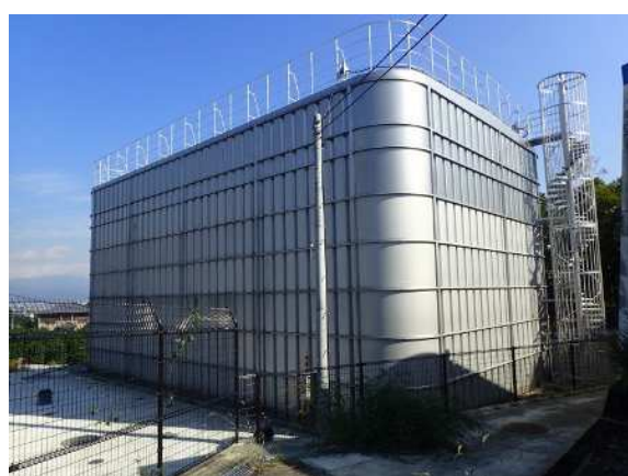
図 2-7 高ノ原配水池②
