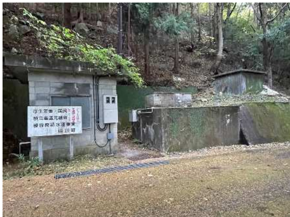
図 2-9 榎谷第 1 配水池
