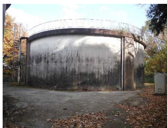
図 2-8 山川中央配水池
