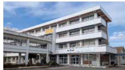
改修を実施する鴨島第一中学校
