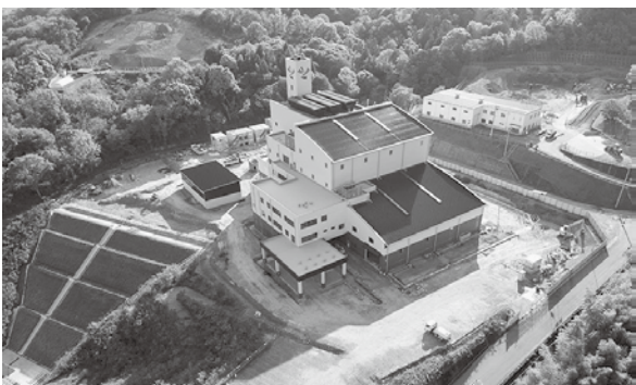
新ごみ処理施設の建設状況(令和7年4月時点)
