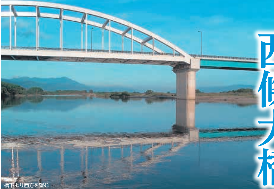
橋下より西方を望む
