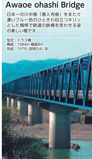
南側より北側を望む
