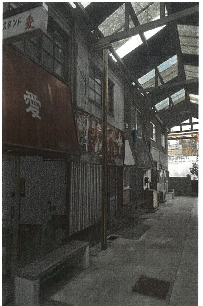
図 8.梁補強後(495-8 前)
