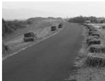
除草材の置き状況
