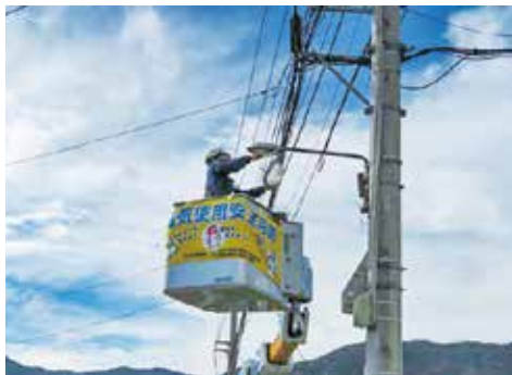
△清掃・点検・点灯確認の様子
