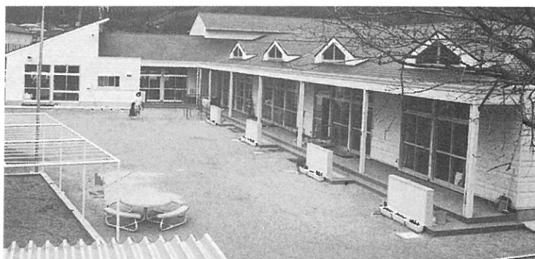
南保育所新築落成 [平成4年]
