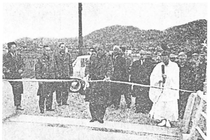
川田川中央橋完成 [昭和39年1月20日]
