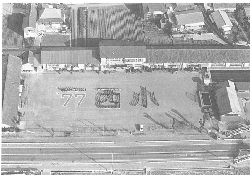
川田西小学校 [昭和52年]
