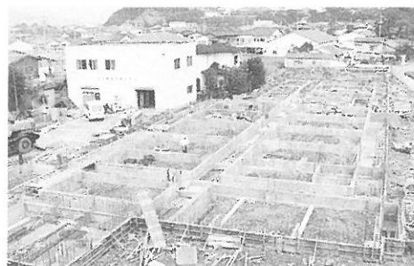
建設中の新庁舎工事 [平成元年]
