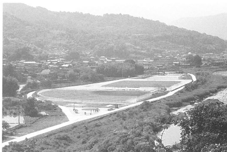
総合スポーツ運動場第一期工事完成 [昭和61年2月10日]
