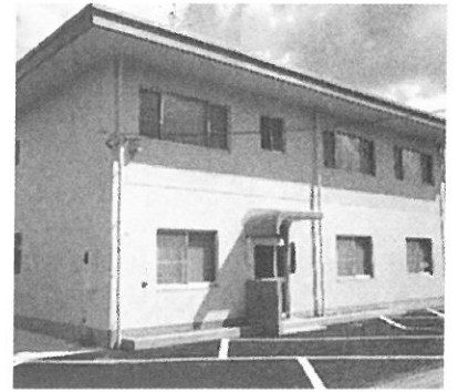
山川中学校寄宿舎「高越寮」完成 [平成元年]
