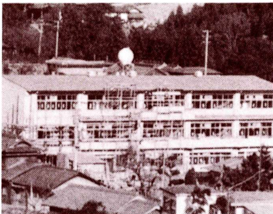
東山小学校新校舎・体育館新築完成
