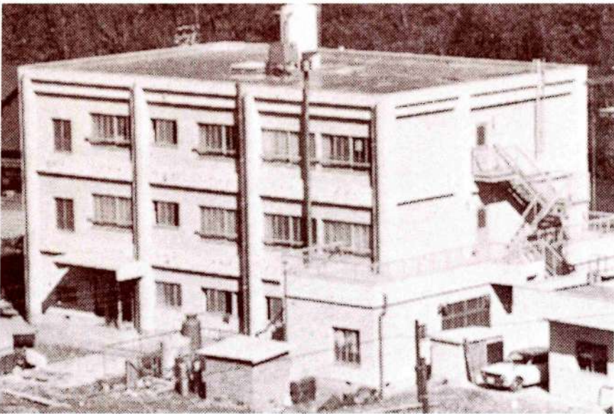
中学校寄宿舎建設工事完成
