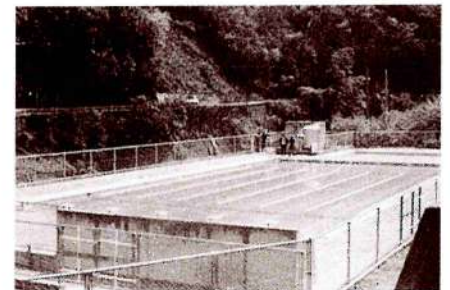
種野小学校プール新設
