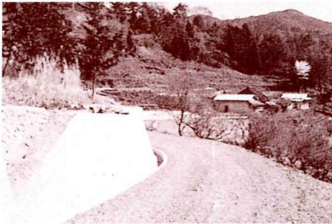
農道勘蔵線新設
