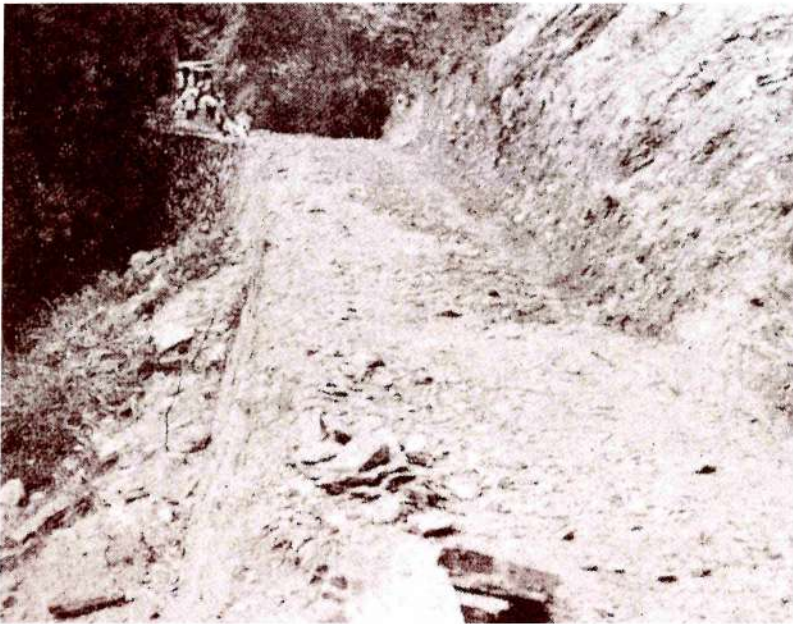
村道小竹線新設
