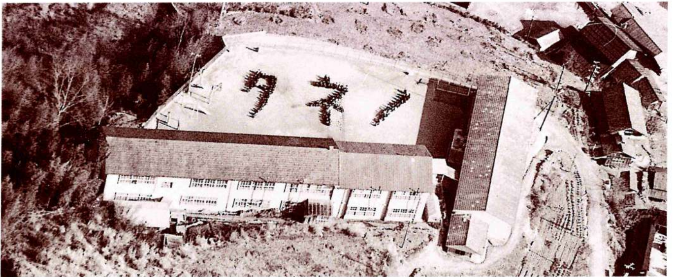
種野小学校新設工事
