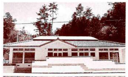
デイサービスセンター新築完成
