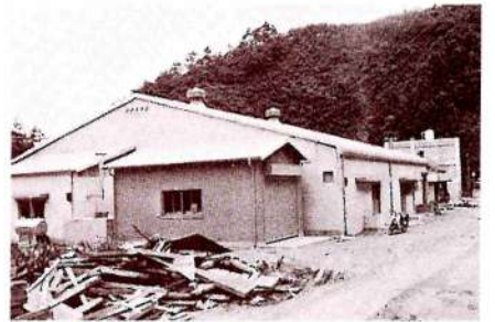
稚蚕共同飼育所建築工事完成
