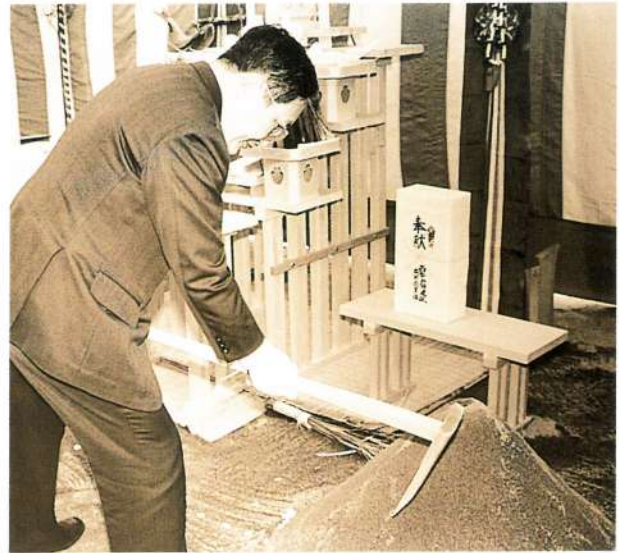
鴨島町新庁舎建設工事起工(平成5年3月8日)
