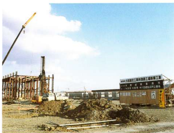
建設工事中の誘致企業(鴨島中央工業団地)
