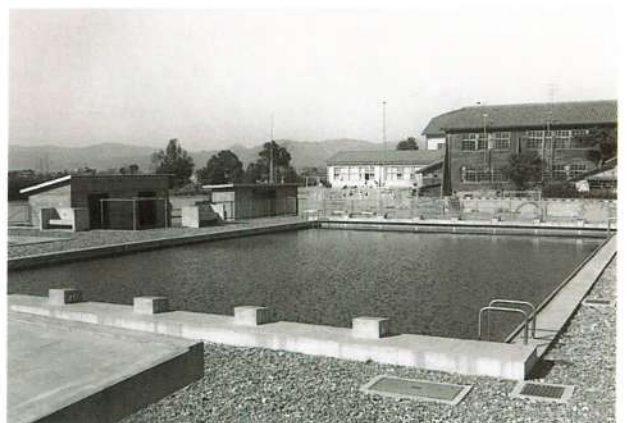
森山小学校にプール完成(昭和42年7月)
