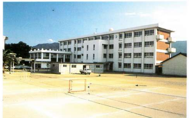
改築された鴨島東中学校
