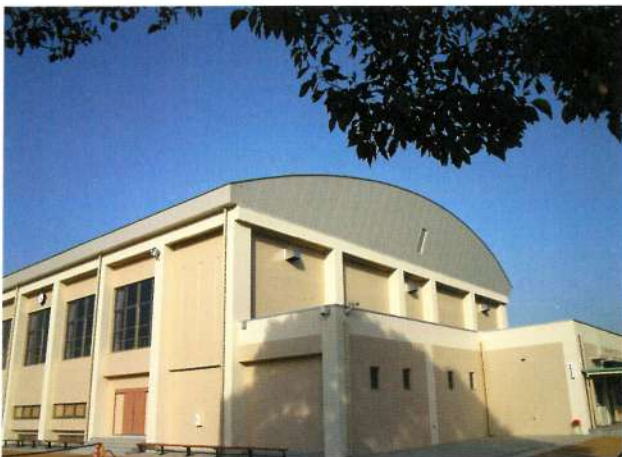
鴨島東中学校屋内運動場完成(平成16年3月)
