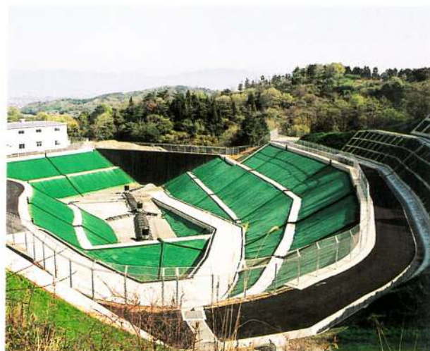
一般廃棄物最終処分場完成(平成15年3月)
