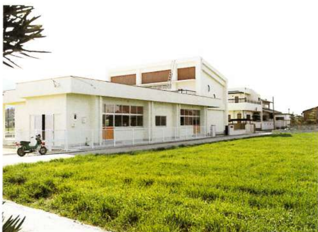
改築された西麻植幼稚園園舎(昭和58年3月)
