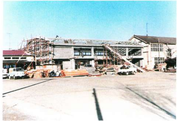
講堂を屋内運動場に改築中の上浦小学校
