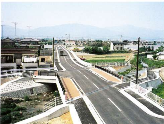
町道「喜来上下島線」が全線開通。町の中心部から県道徳島-鴨島線へのアクセスも便利になった
