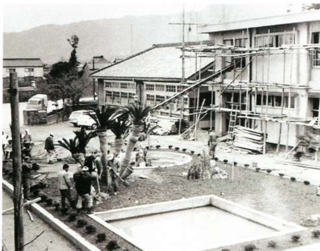
改築中の西麻植小学校
