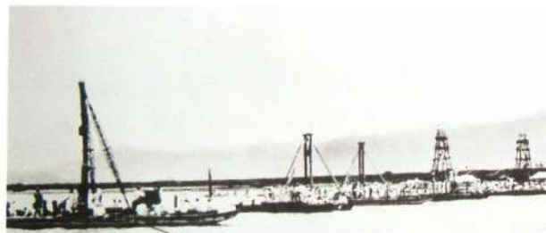
昭和2年、阿波中央橋の木橋の架設作業が行われた。しかし、突貫工事のため1週間後の台風で流出した(写真提供:徳島新聞社)
