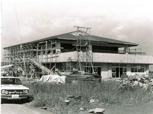
建設中のコミュニティセンター
