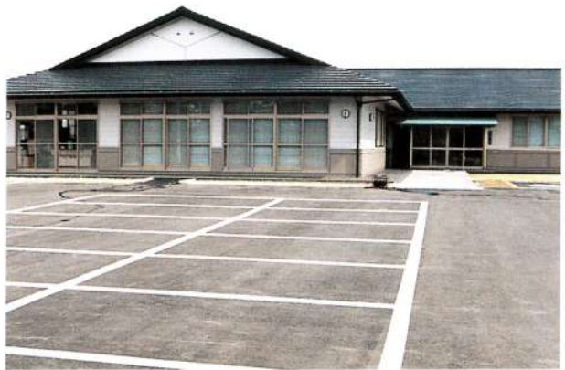
西麻植公民館新築移転(平成9年3月)
