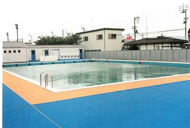
鴨島東中学校プール完成（平成7年3月）
