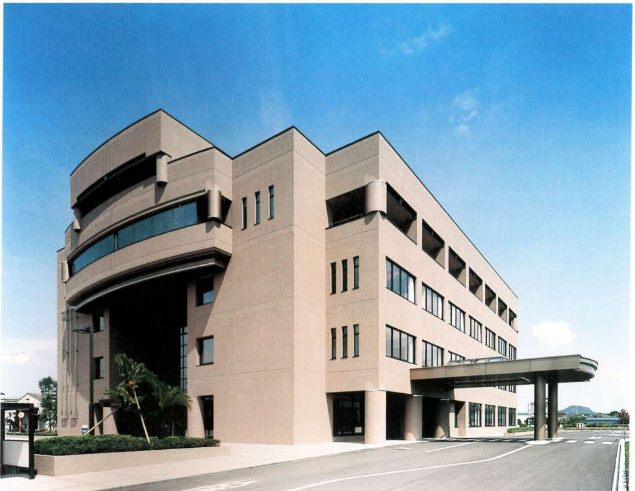
完成した町役場新庁舎
