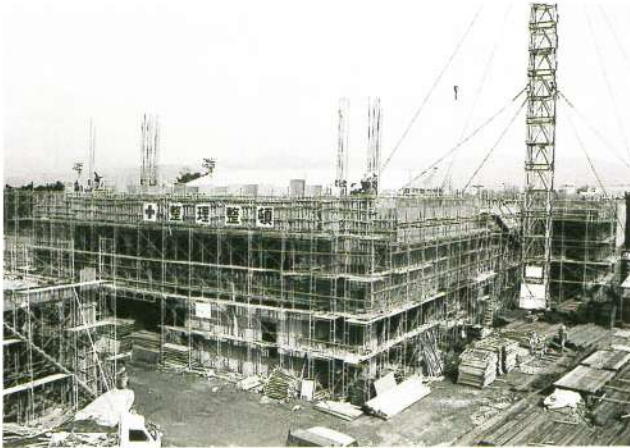
工事中の鴨島町中央公民館
