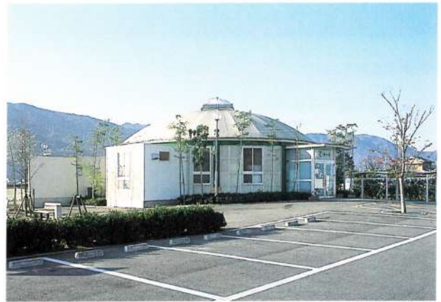
営業を開始した鴨島温泉「鴨の湯」(平成10年1月)
