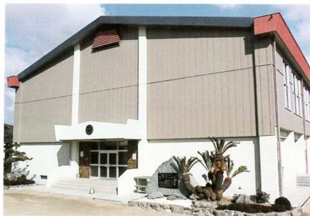
完成した牛島小学校屋内運動場 (昭和56年3月)
