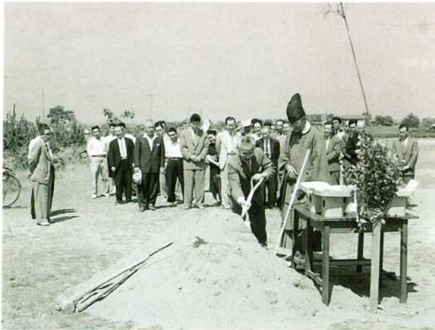
鴨島町立鴨島商業高等学校起工式
