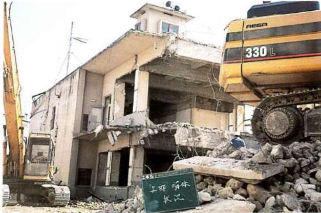
解体中の旧役場庁舎
