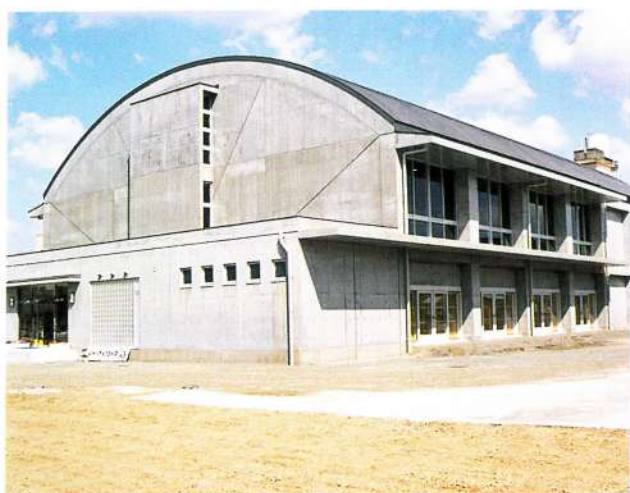
鴨島小学校屋内運動場完成(平成12年3月)
