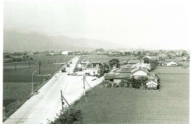
国道192号線が交通の中心となる(現在の牛島小学校付近)
