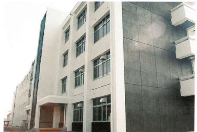
鴨島第一中学校校舎改築(昭和53年11月)
