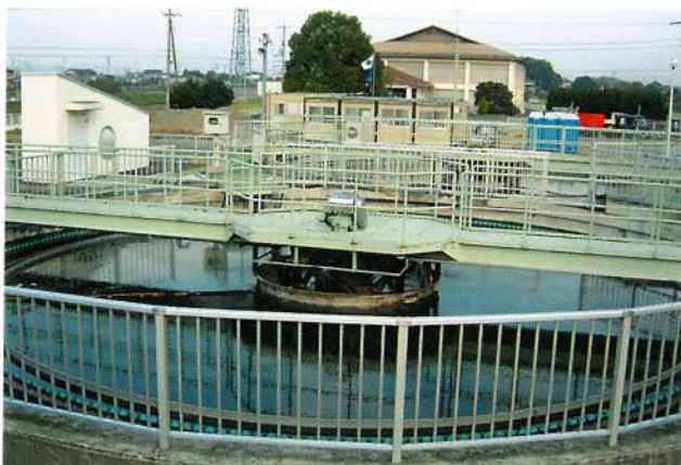
鴨島中央浄化センターの最終沈殿池
