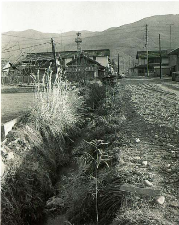
工事中の飯尾上下島線(昭和45年頃)
