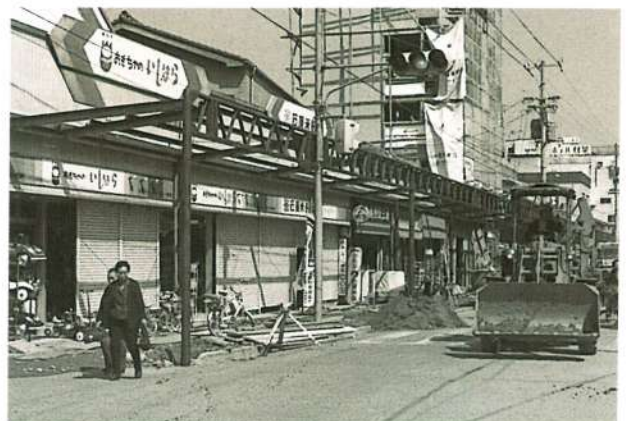
駅前中央通り、アーケード・カラー舗装工事始まる
