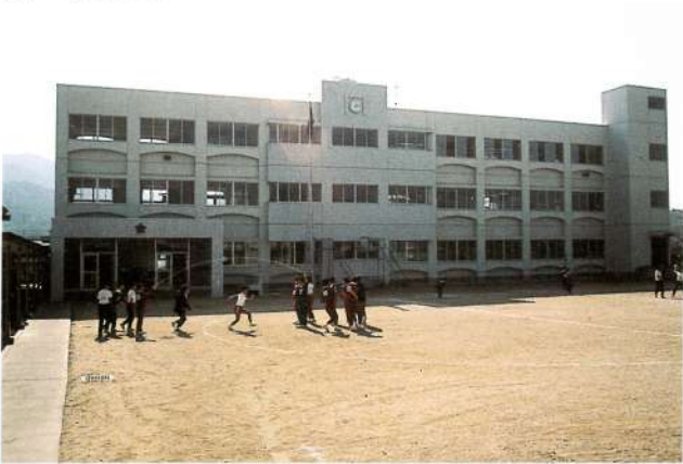
上浦小学校校舎改築(昭和60年3月)
