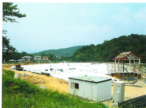
役割を終え適正閉鎖工事中の不燃物埋立地(平成16年7月撮影)
