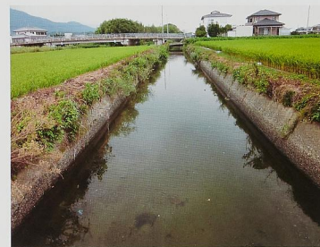
ぶちはコンクリートで固められている
