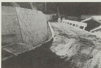
改修中の道路 (高野-桑内線)
