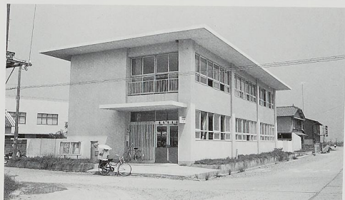
▲竣工当時の鴨島郵便局（昭和36年）
