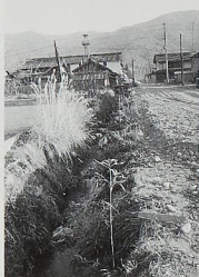
▶ 着工された町道飯屋上下島線 (昭和45年)
