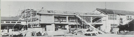
▲ 講堂を体育館に改装中の上浦小学校 (昭和45年)
