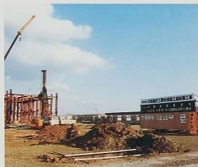
▲工場新設中の誘致企業
