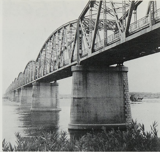
本町を基点として阿北路を結ぶ交通の要衝となっている阿波中央橋
