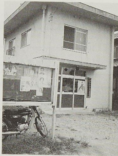
駐在所 (町内に4か所) 山崎警察官駐在所, 山川警察官駐在所 瀬語警察官駐在所, 西川田警察官駐在所
