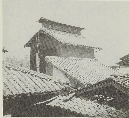
薪を使った煙草乾燥室の建物
