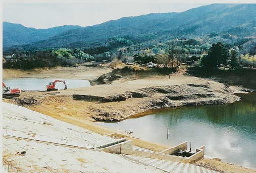
(水ぬきをした大正池)
