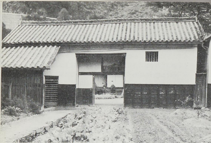
川田山村庄屋屋敷の門
