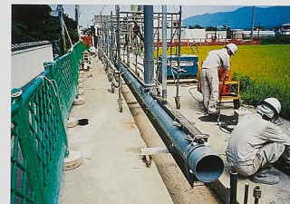
下水管のうめこみ工事
