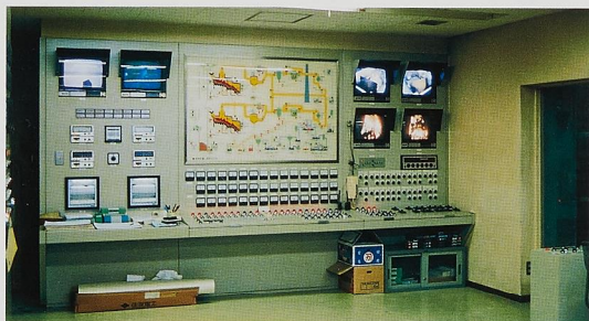
清掃センターの管理室のようす
