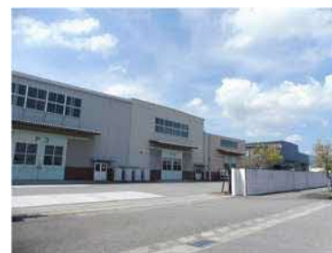
鴨島中央工業団地
