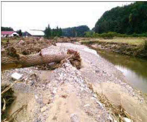
豪雨による河川増水で被災した農地
