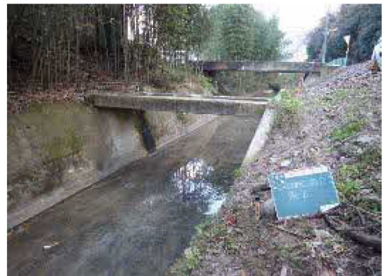
査定前着工により復旧した水路
