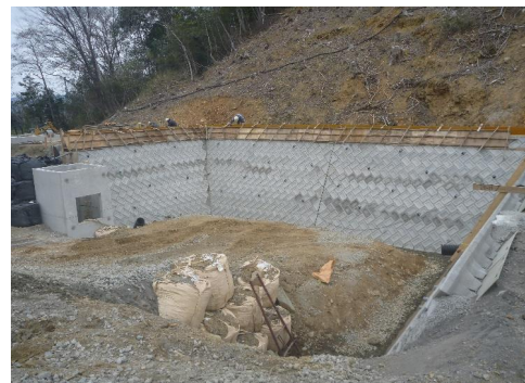
(写真5) 調整池工
