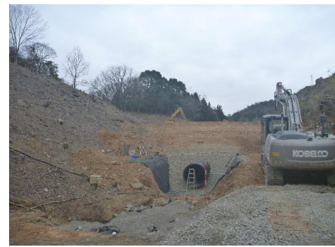
(写真6) 暗渠排水管
