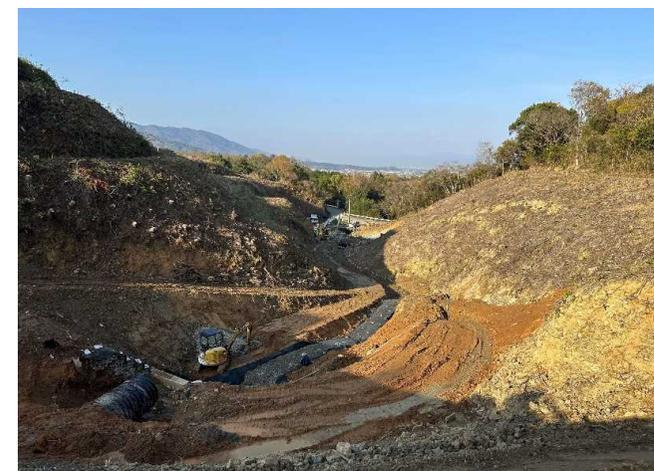
(写真1) 地下配水管設置中
