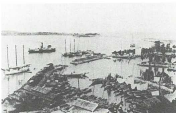
【角川日本地名大辞典一徳島県一】旧津田港（徳島市）
