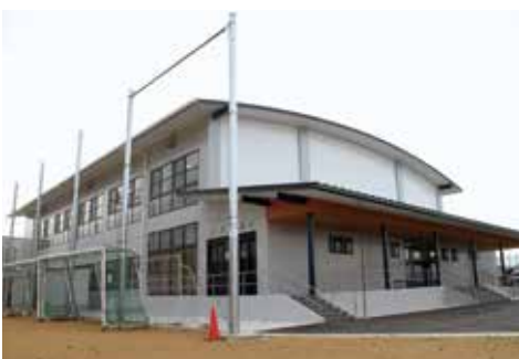
山瀬小学校屋内運動場
