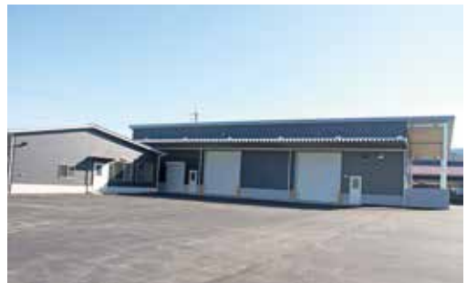
△地域内物資輸送拠点として整備された吉野川市防災備蓄センター（山川町春日）
