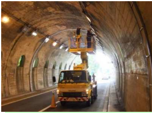
高所作業車による定期点検
