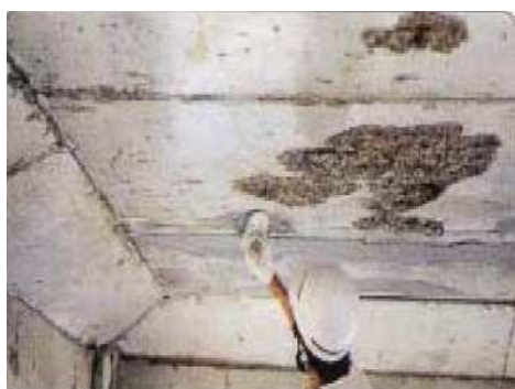
セメントモルタルによる断面修復
