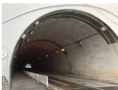
可視樹脂繊維シートによる当て板工
