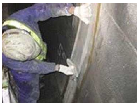
溝切の設置（溝切り工）
