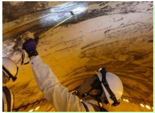
点検ハンマーによる打音検査
