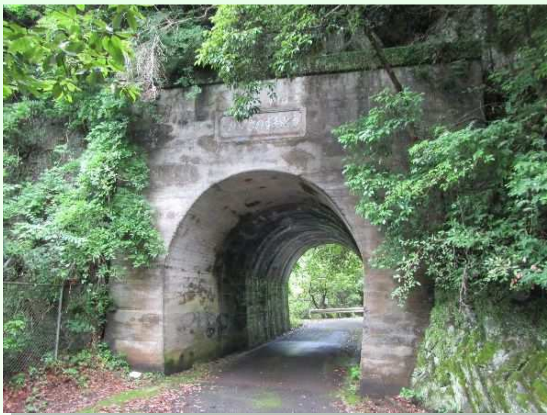
迎坂トンネル
