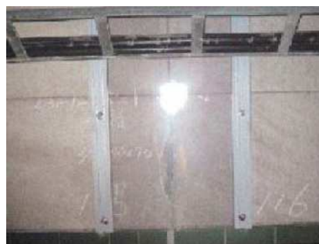
樋の設置（導水樋工）
