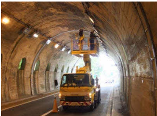
高所作業車による定期点検
