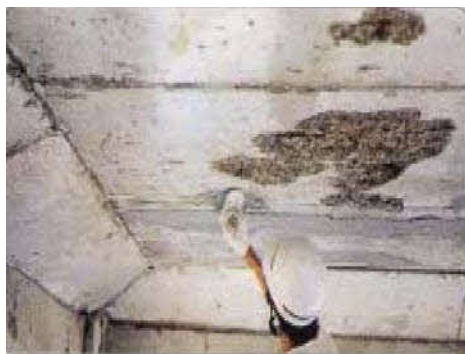
セメントモルタルによる断面修復
