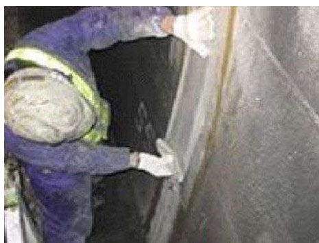
溝切の設置（溝切り工）
