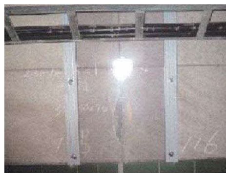
樋の設置（導水樋工）
