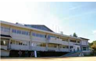
多目的交流拠点施設として整備される旧種野小学校
