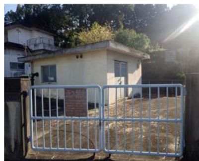
図 2-8 川島第2 高区受水場
