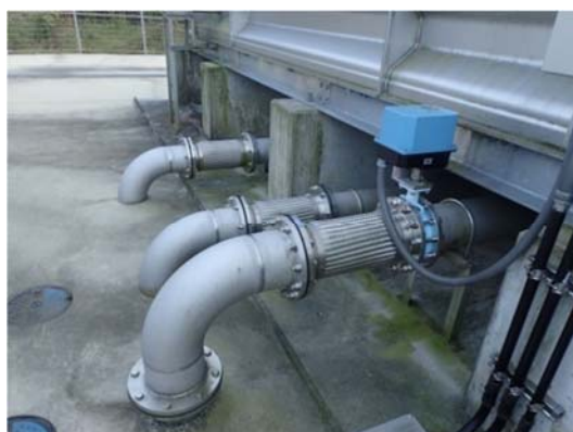
図 3-2 川島第 3 高区配水池 緊急遮断弁
