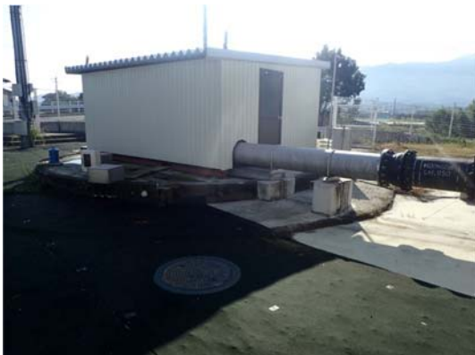
図 2-1 鴨島町取水井
