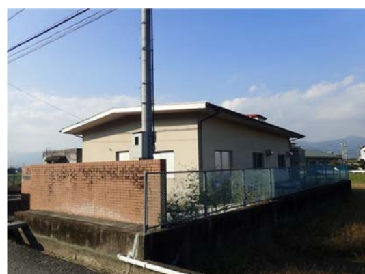
図 2-4 山川町浄水場
