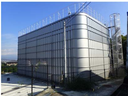
図 2-5 高ノ原配水池②
