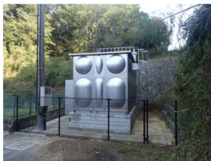
図 2-7 ハイランドポンプ場
