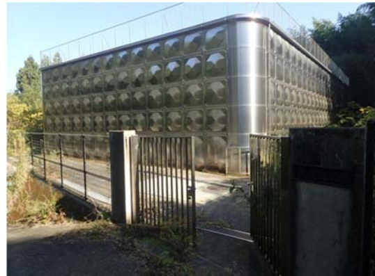
図 2-6 川島低区配水池②
