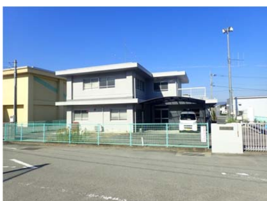
図 2-3 川島町浄水場
