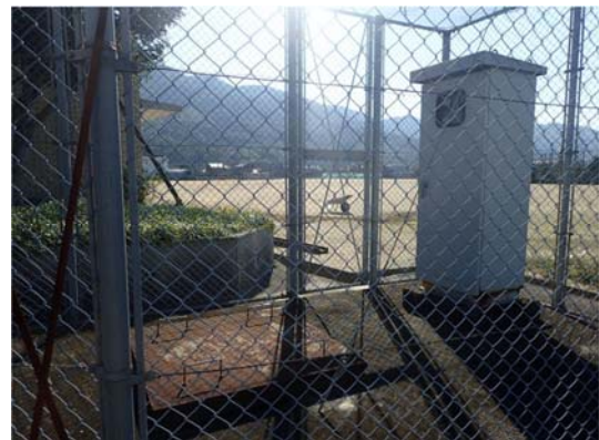
図 2-2 川島町取水井(3号井)
