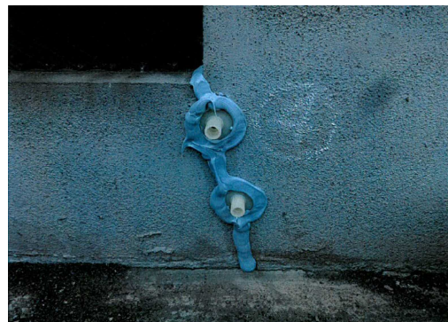
基礎ひび割れ修繕状況
