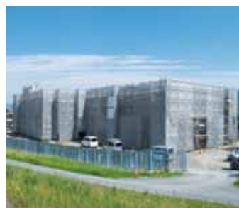
西消防署新築工事
