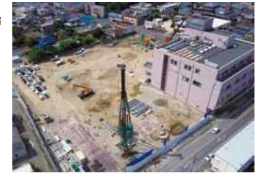
8月下旬の建設現場
