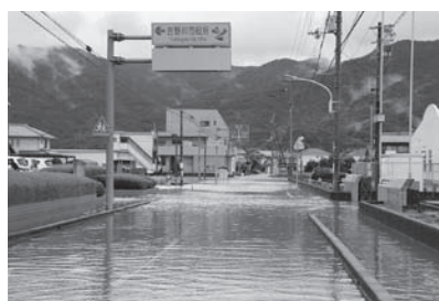
台風16号により冠水した道路
