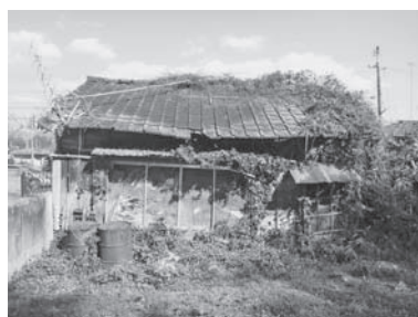
老朽化した空き家
