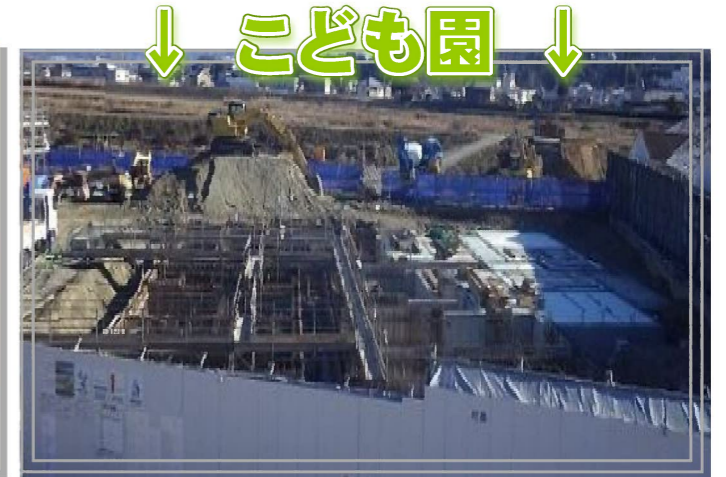
コンクリート打設工事
