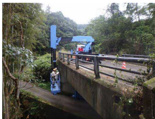
橋梁点検車による点検(八幡西橋)
