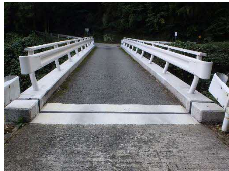
城戸橋(修繕後)
