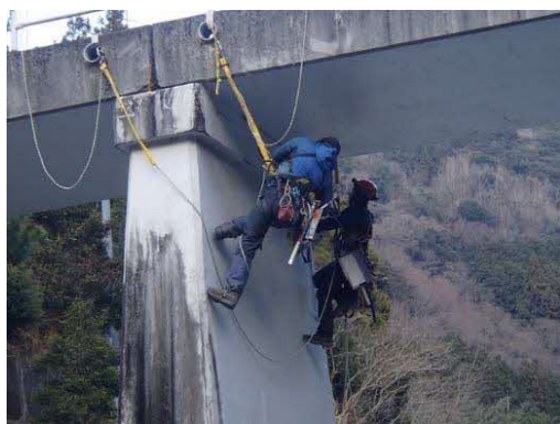
特殊高所作業による点検(広瀬橋)
