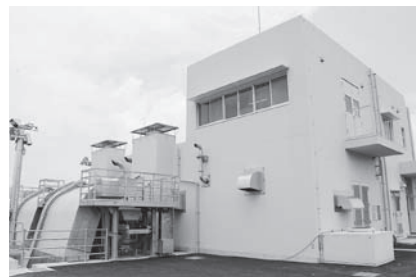
完成したほたる川排水機場
