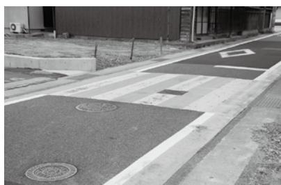
道路のカラー舗装
