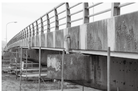
耐震補強工事中の十二騎橋
