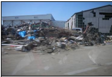
地震と津波の被害現場
