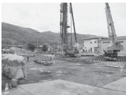
工事が進められている、新給食センター
