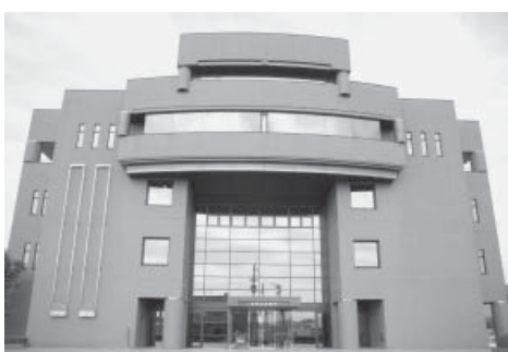
市役所機能を本庁舎に集約します
