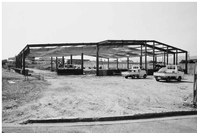
食鳥工場建設地
