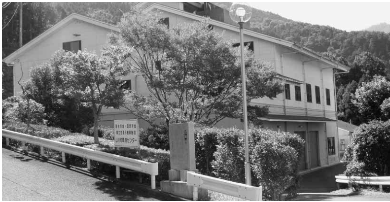
山川町環境センター
