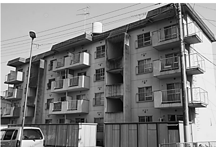
今年度改修を行う湯立団地
