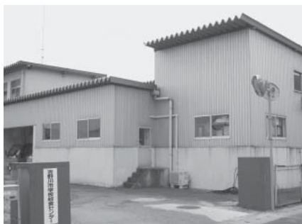
新たに建て替えられる給食センター
