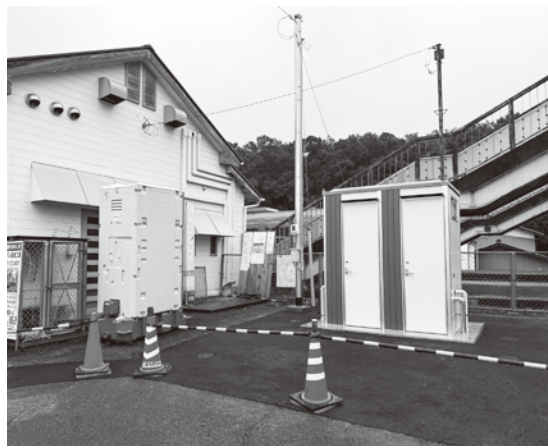
JR阿波川島駅周辺トイレの工事の様子
