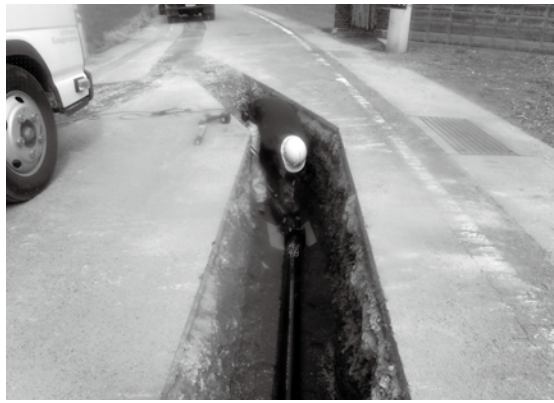
老朽管布設替工事
