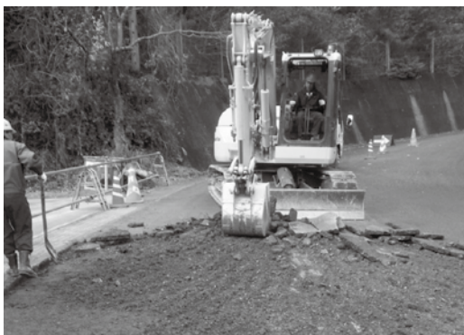
アスファルト舗装の補修状況
