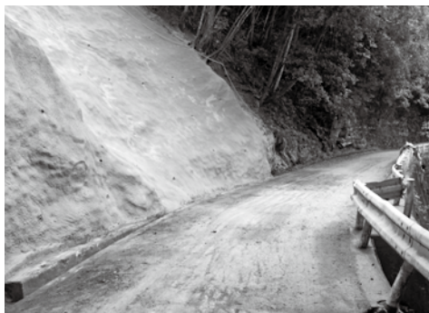
久宗・桑内線法面对策工事
