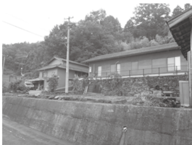
老朽危険空き家（撤去後）
